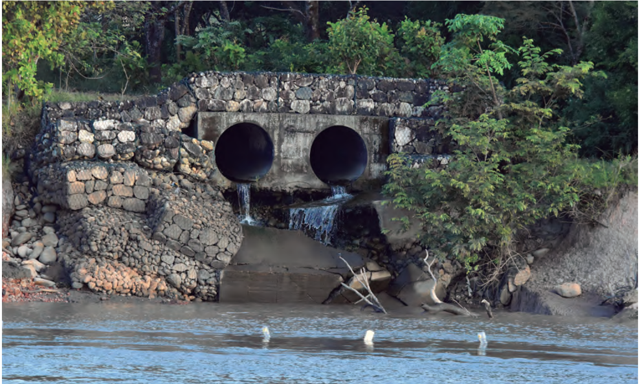
Vertimiento de aguas residuales de origen urbano, en el municipio de Orocué.
